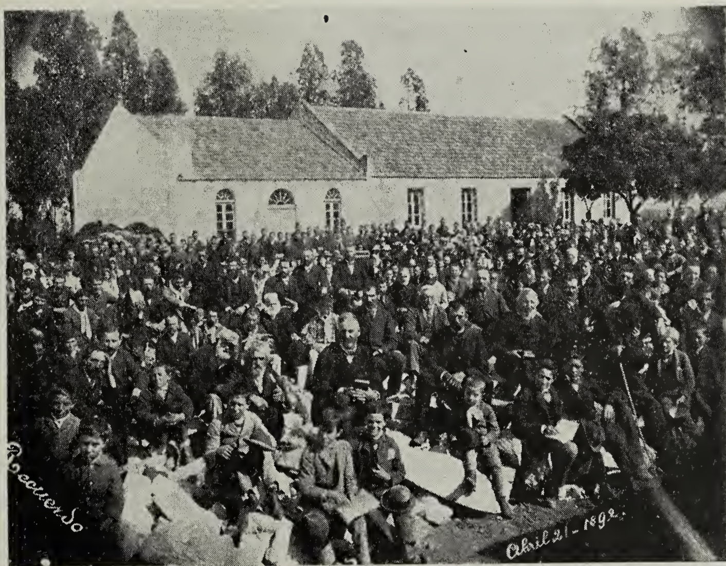
Colocación de la piedra fundamental del Templo de Colonia Valdense (21 de abril de 1892)
